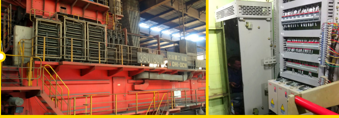
江西新余钢铁 4 台 360T 铸造吊 主钩电机 500KW×2 QY2-2000S/T5 525V 一拖二驱动
