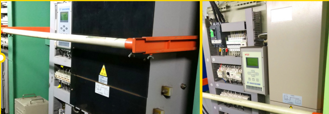
宝钢条钢事业部 15 台桥吊 全机构采用 QY3A 系列，转子采用 JSR1 电机无触点控制器。
